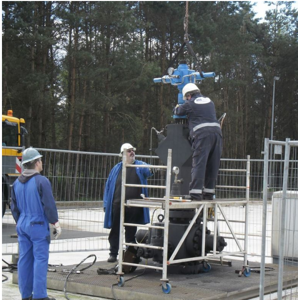
Montage eines Preventers auf den Bohrlochkopf in Vorbereitung auf Bohrlochmessungen
